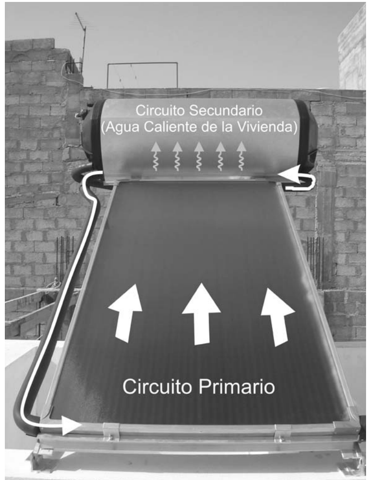
Equipo Compacto Temposifón de Circuito Cerrado 180 litros (habitual en viviendas). Ramón García Déniz
